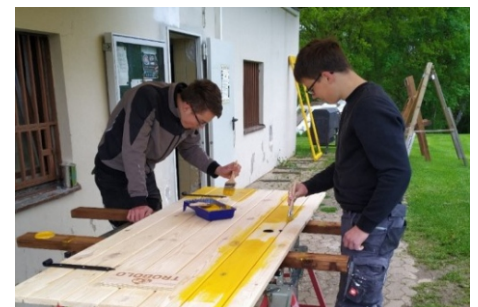
Streichen der Tür der Trockentrenntoilette; Foto: SV Michelfeld
