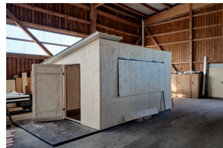
Verkaufshütte im Bau, FW Nitzlbuch; Foto: L. Lindner
